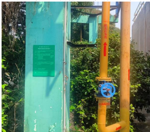
应急管道流向标识及现场处置卡
